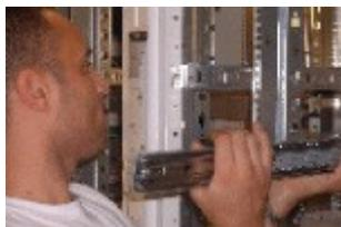
Les baies sont mises à nu, les vis et écrous cage sont récupérés. Elles sont désolidarisées, les jupes de maintien sont enlevées. Si les serveurs ne sont pas réimplantés dans la même baie ou à la même position qu'au départ, les rails sont démontés et repérés par rapport au serveur correspondant. Les serveurs sont ensuite pris en charge par l'équipe emballage.
