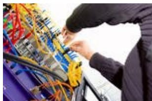
Les baies sont réimplantées, verrouillées au sol, leurs jupes de maintien installées dans les règles de sécurité et conformément à la garantie constructeur. Les serveurs sont mis en place en application du plan de repérage défini en phase préparatoire. Après l'implantation des serveurs et éléments associés dans les baies, une première validation a lieu avec le Client ; elle est consignée sur les fiches de suivi. Les opérations de reconnexion démarrent après validation de cette étape.
